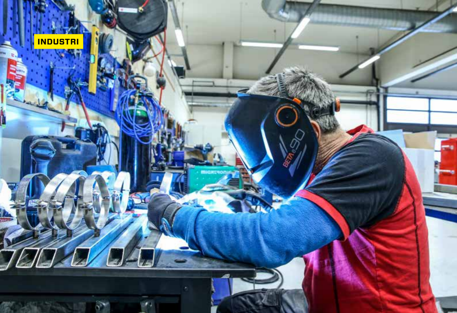
Allsidig: Arve Borgund, en av 15 ansatte i Øen Kuldeteknikk, i ferd med å sveise røroppheng. Han forteller at han har fagbrev både som industrimekaniker, industrirørlegger og kuldetekniker.
